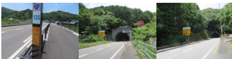
※下関まで135 km地点、須佐トンネル、大刈トンネル
